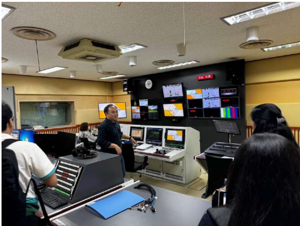
ห้องควบคุม
